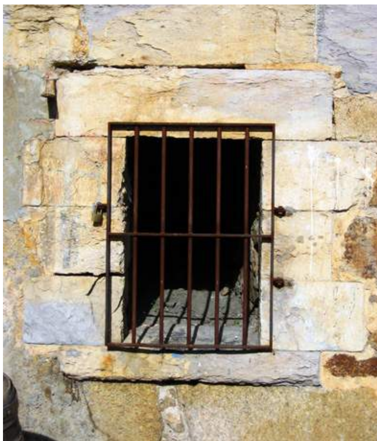
Eixida de la claveguera situada a la part inferior del mur del costat de l'actual restaurant la Terrassa dels Pescadors, 2014. Gabriel Martín. Col. G.Martín. SAMP
