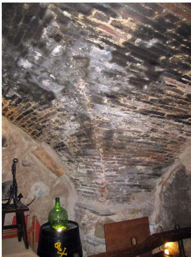
Volta grassa de l'interior de l'antic magatzem de Sebastià Tuèvols, actualment bar El Pirata, 2014.
